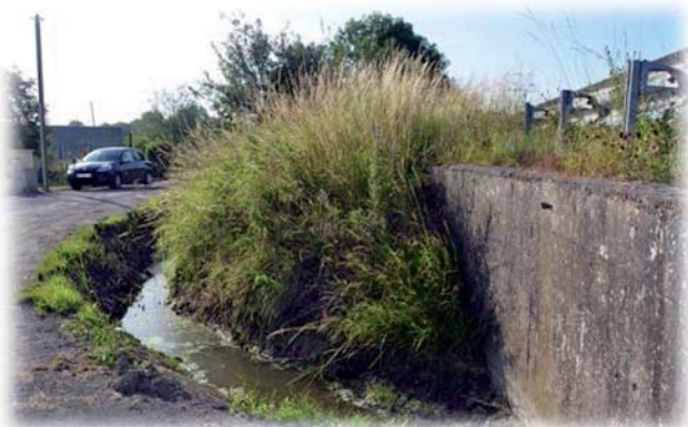
Curage du fossé de la rue Louis Lemaire
