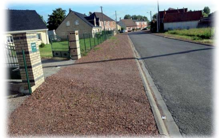
Pose de cailloux sur un tronçon de la rue du vieux pont
