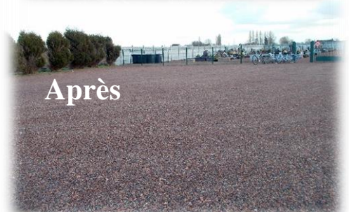
Après Remise en état du parking du nouveau cimetière
