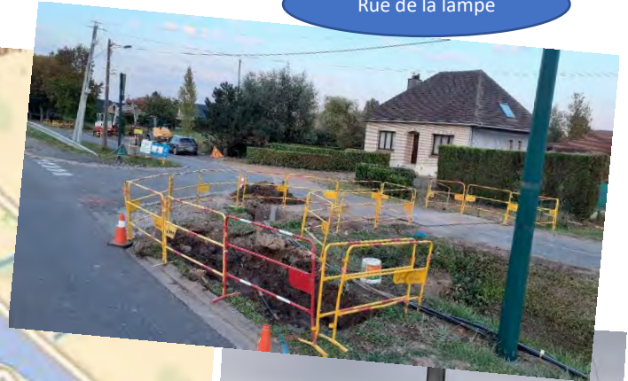
Rue de la lampe
